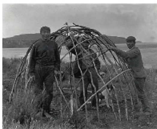
Envarillado de toldo yámana, similar a la estructura chono
