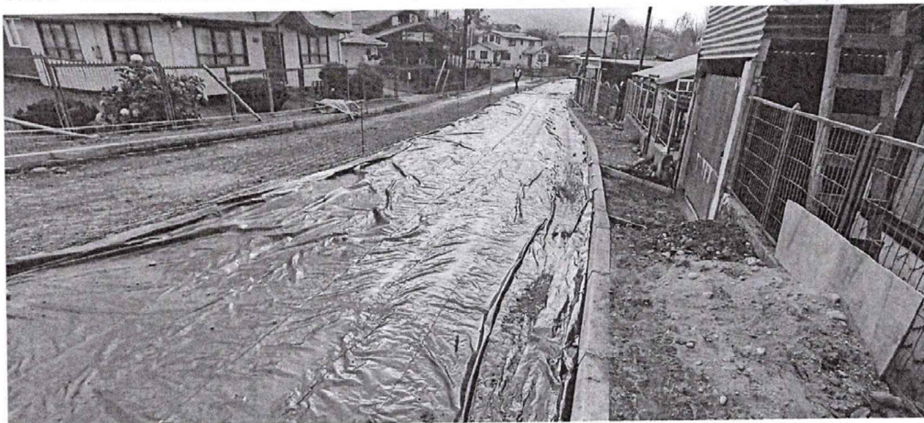
Imagen 6: Hormigonado de media faja de calzada (e: 3,5 m) en calle Ramón Freire, en hormigón de calidad HF45, se recubre con polietileno como membrana de curado.
