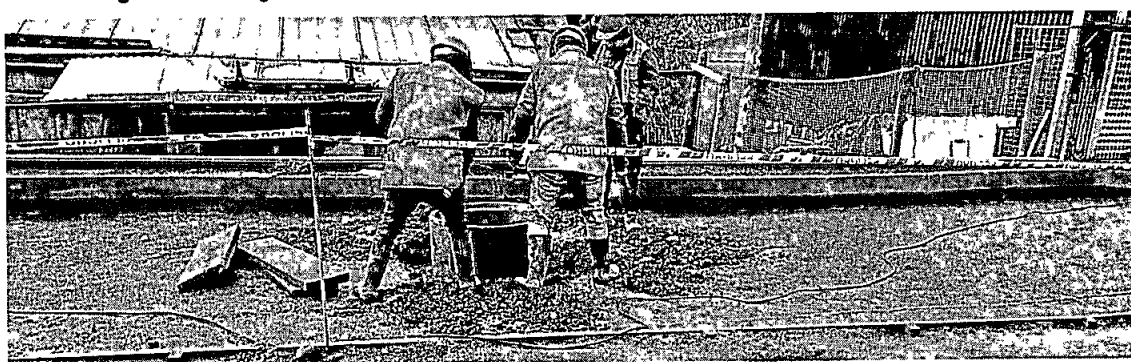
Imagen 3: Hormigonado de sumidero sobre moldaje previamente instalado en calidad GN20.
