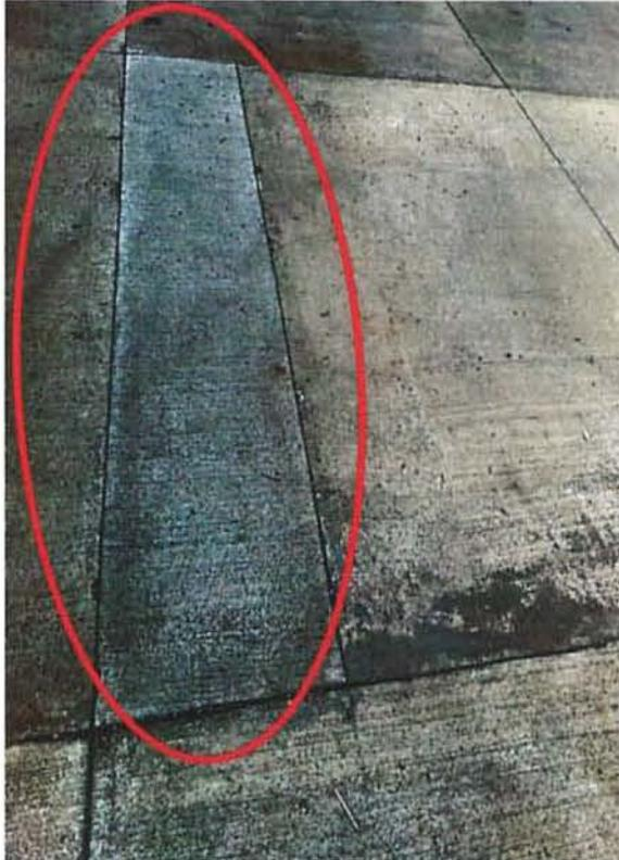
Fotografía N° 1. Paños de hormigón con una superficie menor a 9 m<sup>2</sup>.
