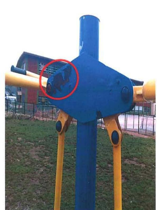
Fotografía N° 8. Elemento oxidado debido a pintura mal ejecutada.
