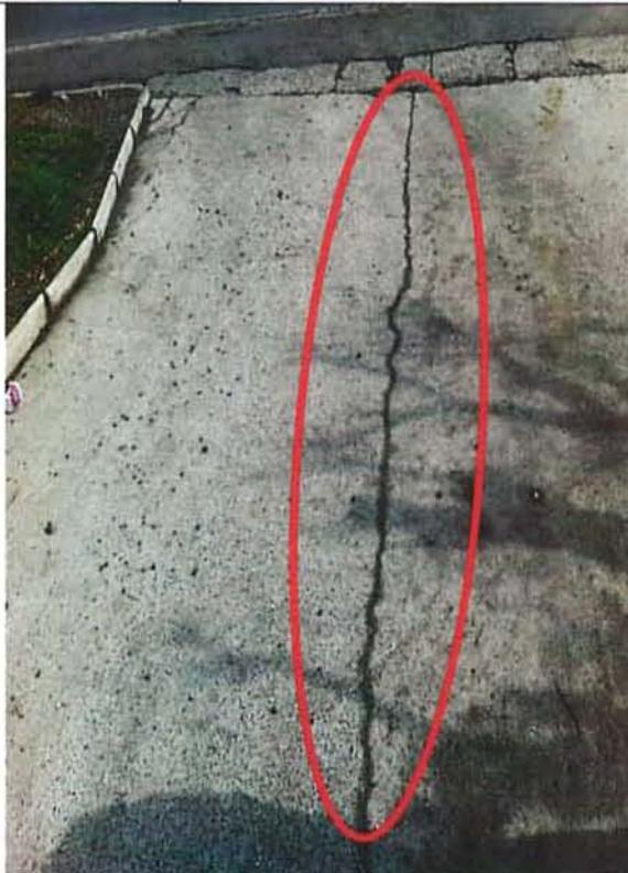
Fotografía N° 3. Acceso fisurado.
