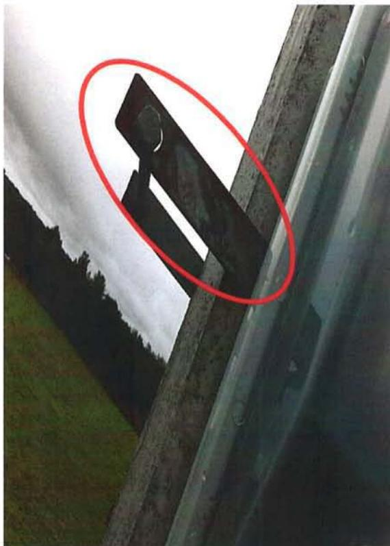
Fotografía N° 7. Soportes oxidados con pérdida del galvanizado.
