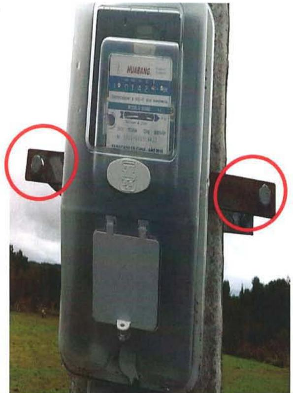
Fotografía N° 6. Soportes oxidados con pérdida del galvanizado.
