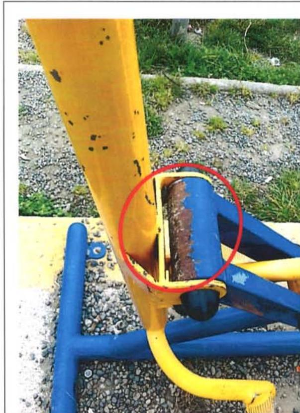
Fotografía N° 9. Elemento oxidado debido a pintura mal ejecutada.
