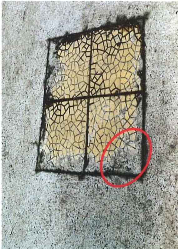
Fotografía N° 5. Baldosas manchadas con mortero de pega.
