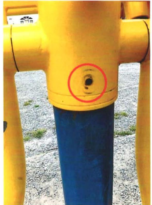
Fotografía N° 10. Ausencia del perno de fijación.
